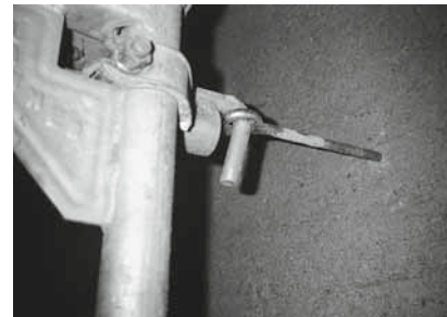
Bild 2: Zug- und druckfeste Verankerung, bestehend aus Bohrdübel und Ringschraube von genügender Tragfähigkeit.
